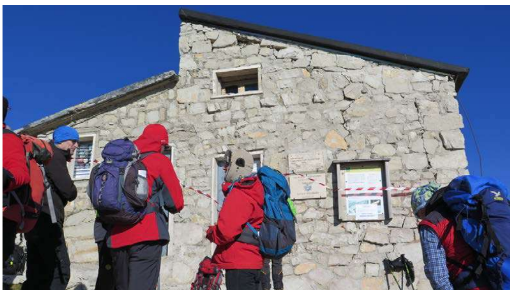
Constatazione delle lesioni provocate dalla crisi sismica.
