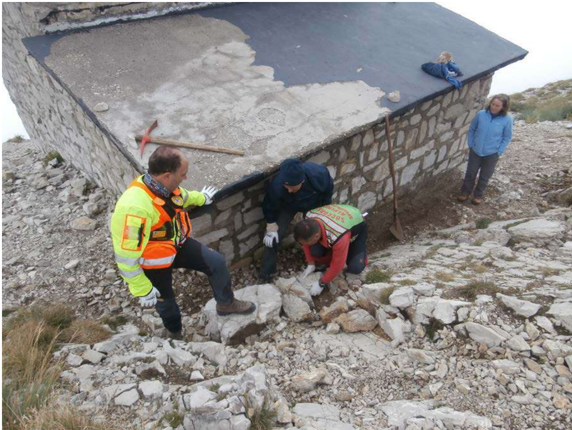
Lavori di manutenzione ordinaria
